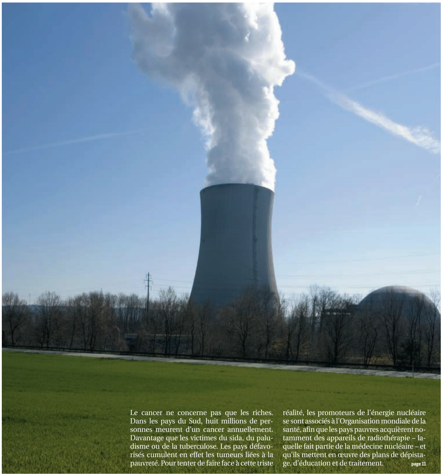
La centrale de Gösgen, dans le canton de Soleure.
